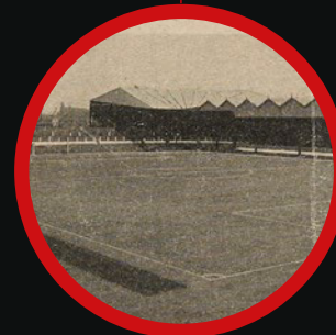
Die Ecken der Südtribüne werden überdacht.
